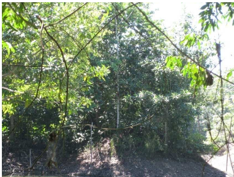
Figura 30: Crecimiento de vegetación natural sobre pilas abandonadas.
