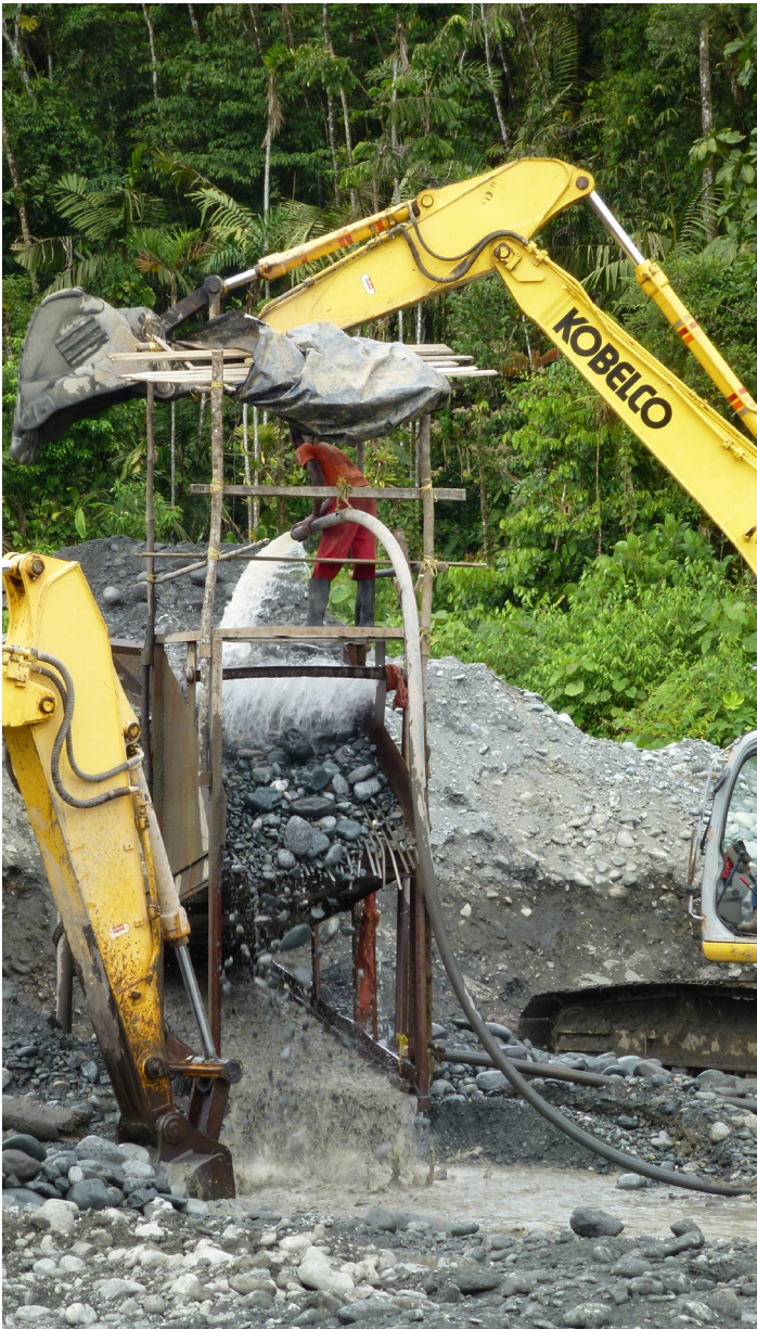
Minería con excavadores en Chocó
