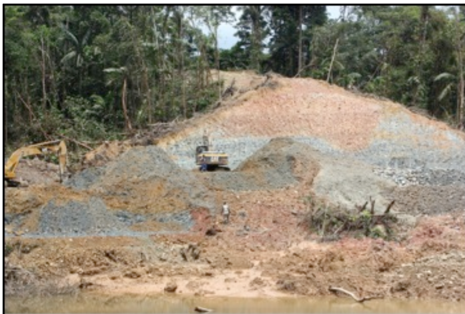
Picture 11. Minería con retro-excavadora
